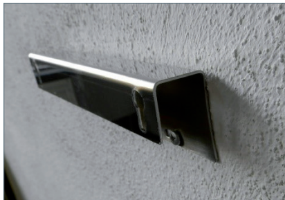
Fig. 6: Ausrichtung der Wandhalterung.
